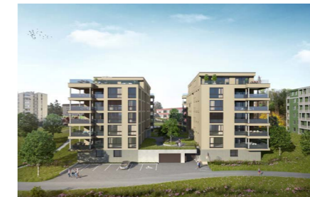
ARBON AM BODENSEE Naturnahes Wohnen «Raum am Ufer» Neubauwohnungen, Verkauf im Baurecht Preis: ab Fr. 548'000.- Zuständig: Concetta Bollinger
