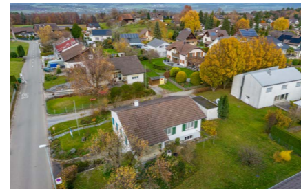
GERLIKON BEI FRAUENFELD Bauland mit bestehender Liegenschaft 963 m 2 Landanteil, Wohnzone 2a Preis: Fr. 1'100'000.- Zuständig: Francine Gaggioli
